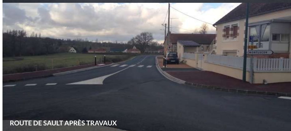
ROUTE DE L'HERMITAGE APRÈS TRAVAUX
