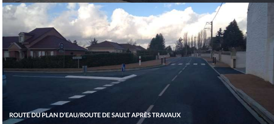
ROUTE DE SAULT APRÈS TRAVAUX
